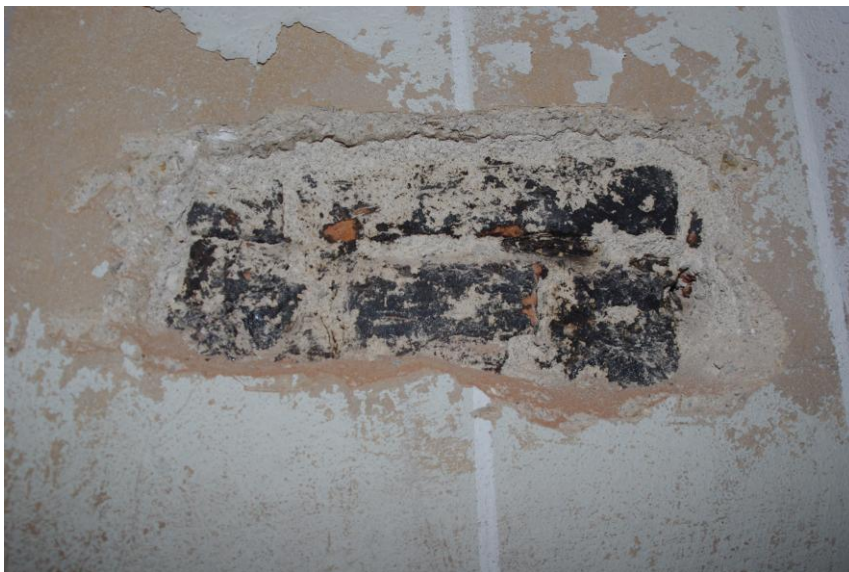
Detailný pohľad na hranicu tmelu a zachovaného originálu. Sonda pod povrch tmelenia. Tehlová plenta z roku 1794 bola upravená smolným náterom. Dôkaz pretrvávajúceho problému vlhnutia steny.
