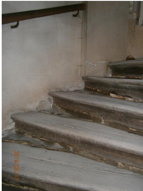
Detail vlhkej podstupnice
